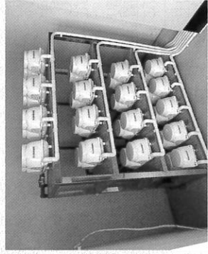
フロアはダイヤフラム式を複数台設置
